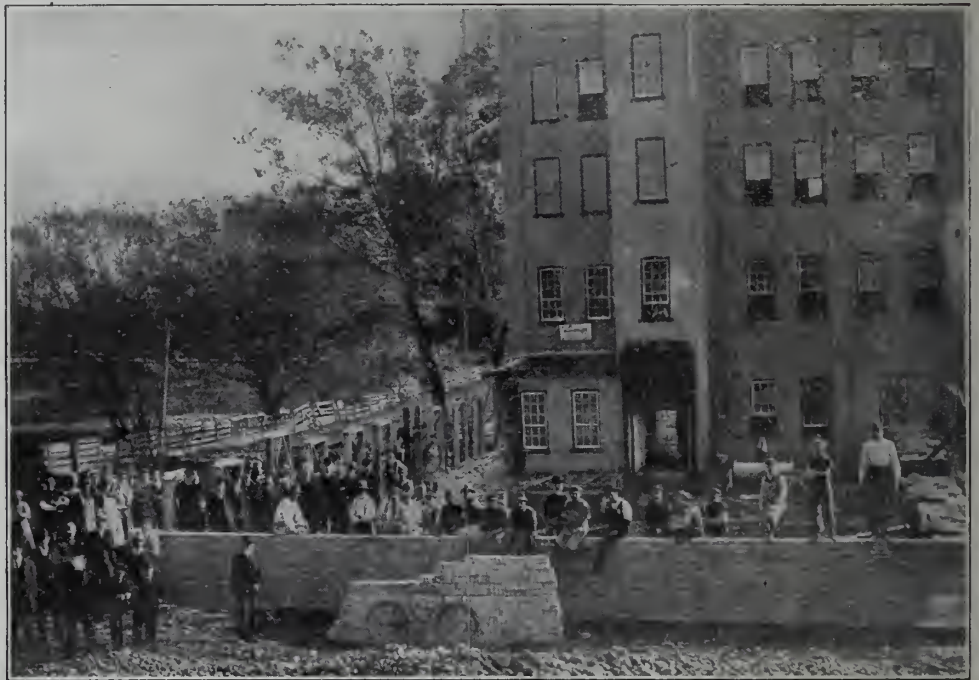
Pose de la pierre angulaire de la partie qui a été ajoutée à la manufacture de la Compagnie Weir Wardrobe, à Mount Forest, le 16 octobre, par le sénateur McMullen, le Maire et le Conseil Municipal.
